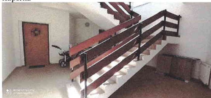
Schodisko bytového domu
